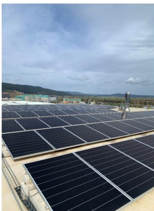
Figura 20 - Sulla sinistra impianto fotovoltaico 40 KW; sulla destra impianto fotovoltaico 70 KW
